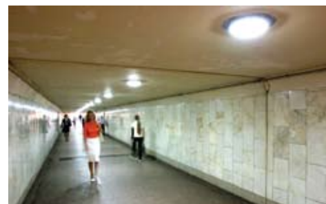
Рис. 3. Установка светильников ДВУ-25 для освещения подземного перехода около станции метро «Рижская»
